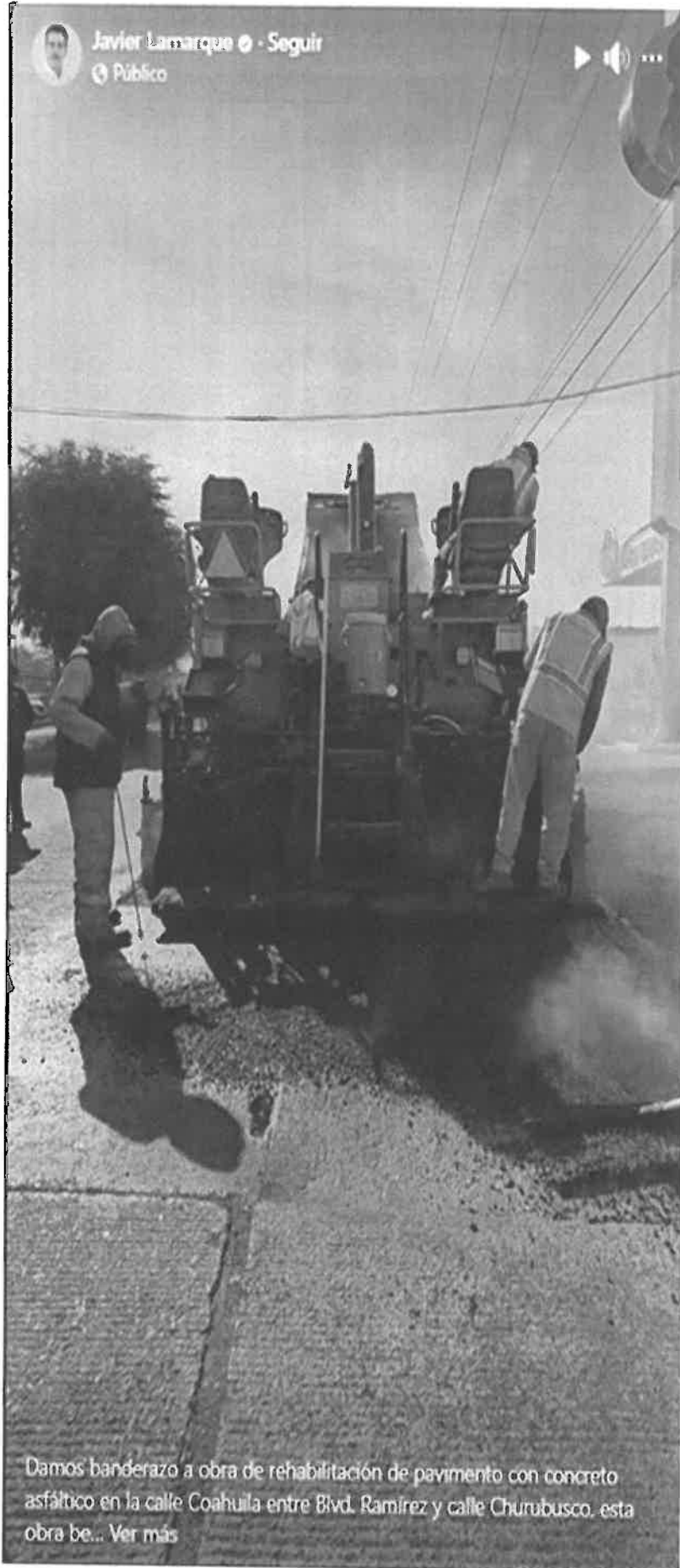
En la imagen anterior se puede observar una máquina utilizada para pavimentación y a varios trabajadores de la construcción, sobre una calle. -----
